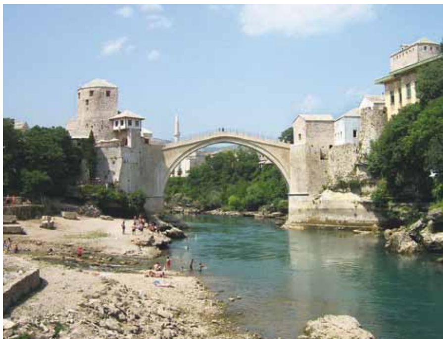
Neue Alte Brücke «Stari Most», Juni 2006, Foto: Mhare.
