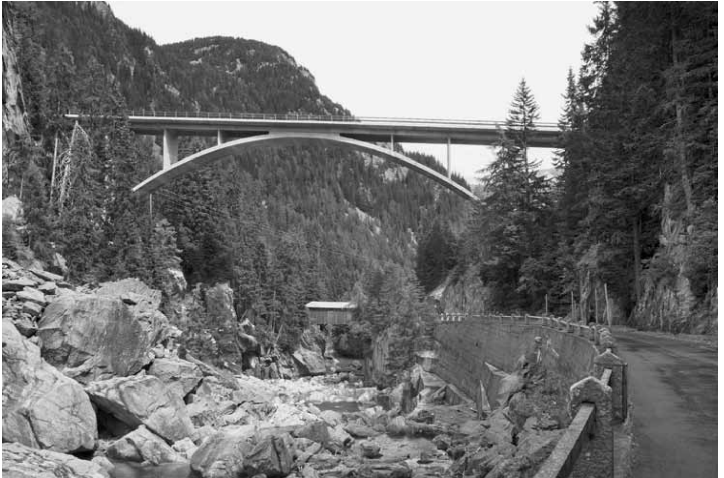
Hinterreihnbrücke Crestawald von Christian Menn (BJ 1958), Foto: Christian Menn, 1959.
