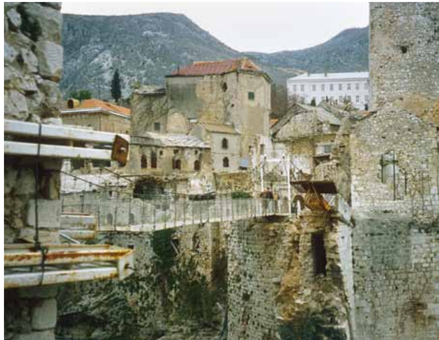
Behelfsbrücke über den Fluss Neretva, Juli 2004, Foto: Schrottie.
